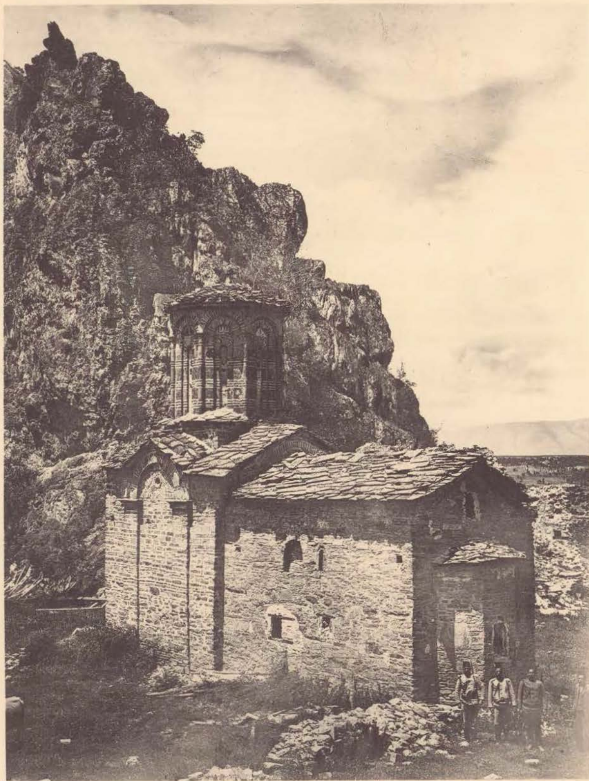
134. Saint-Nicolas, sur la Treska. Vue du sud-est.
